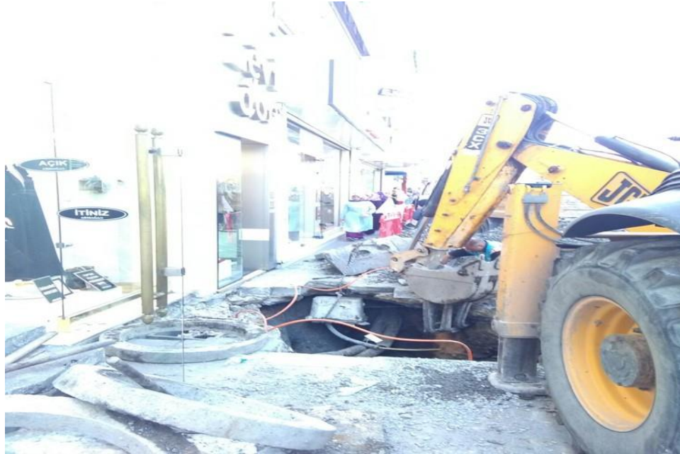
Şekil 2.9. Kazı çalışmalarından örnek fotoğraflar
